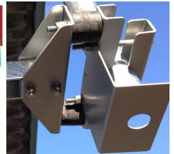
11. Glisser le mât de haut en bas, serrez fermement les mâchoires en équilibrant le serrage des boulons.
