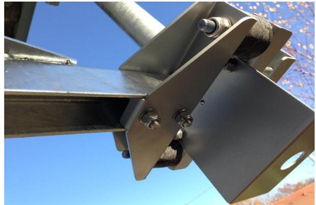
10. Equipez la console basse avec l'équerre de sécurité permettant de soutenir le mât par le bas en cas d'un serrage défaillant dans le temps. Le mât ne doit pas reposer de tout son poids sur cette équerre. Evitez même si possible le contact.
